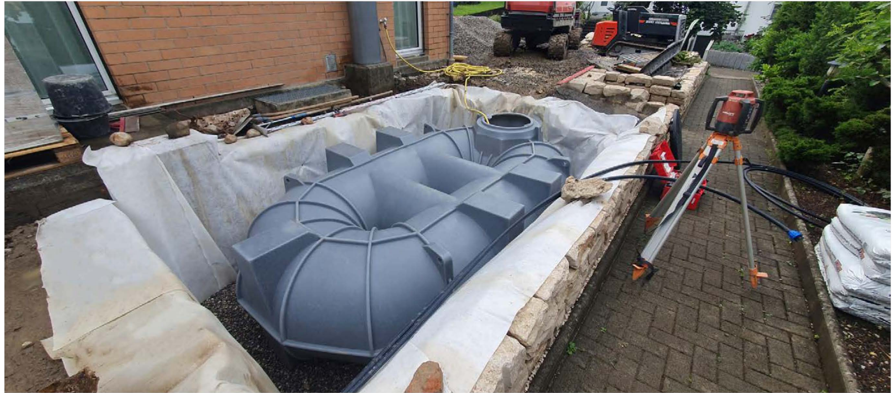
Einbau eines unterirdischen Regenwassertanks bei einem Umbauprojekt. Solche Zisternen sammeln Regenwasser vom Dach und stellen es für Gartenbewässerung, WC-Spülungen oder Waschmaschinen zur Verfügung.
